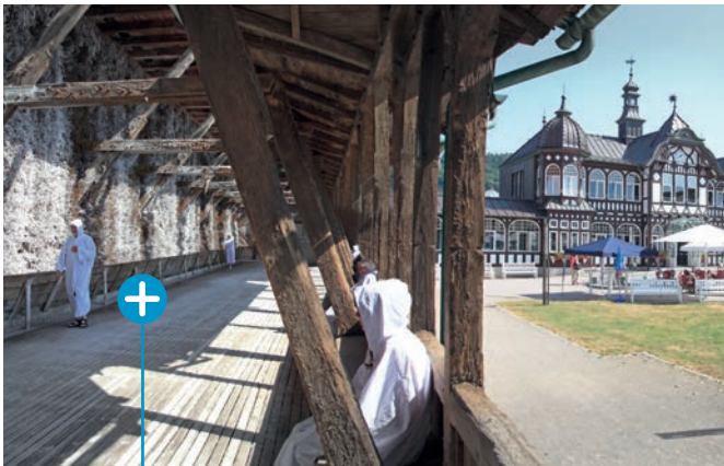
Gradierwerk Bad Salzungen
